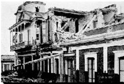
Casa en Mayagüez de techo plano en ladrillos. Frente a esta se apreciaba un poste telefónico hecho de concreto reforzado, roto por el terremoto de 1918. (Suministrada/<http://redsismica.uprm.edu>)
